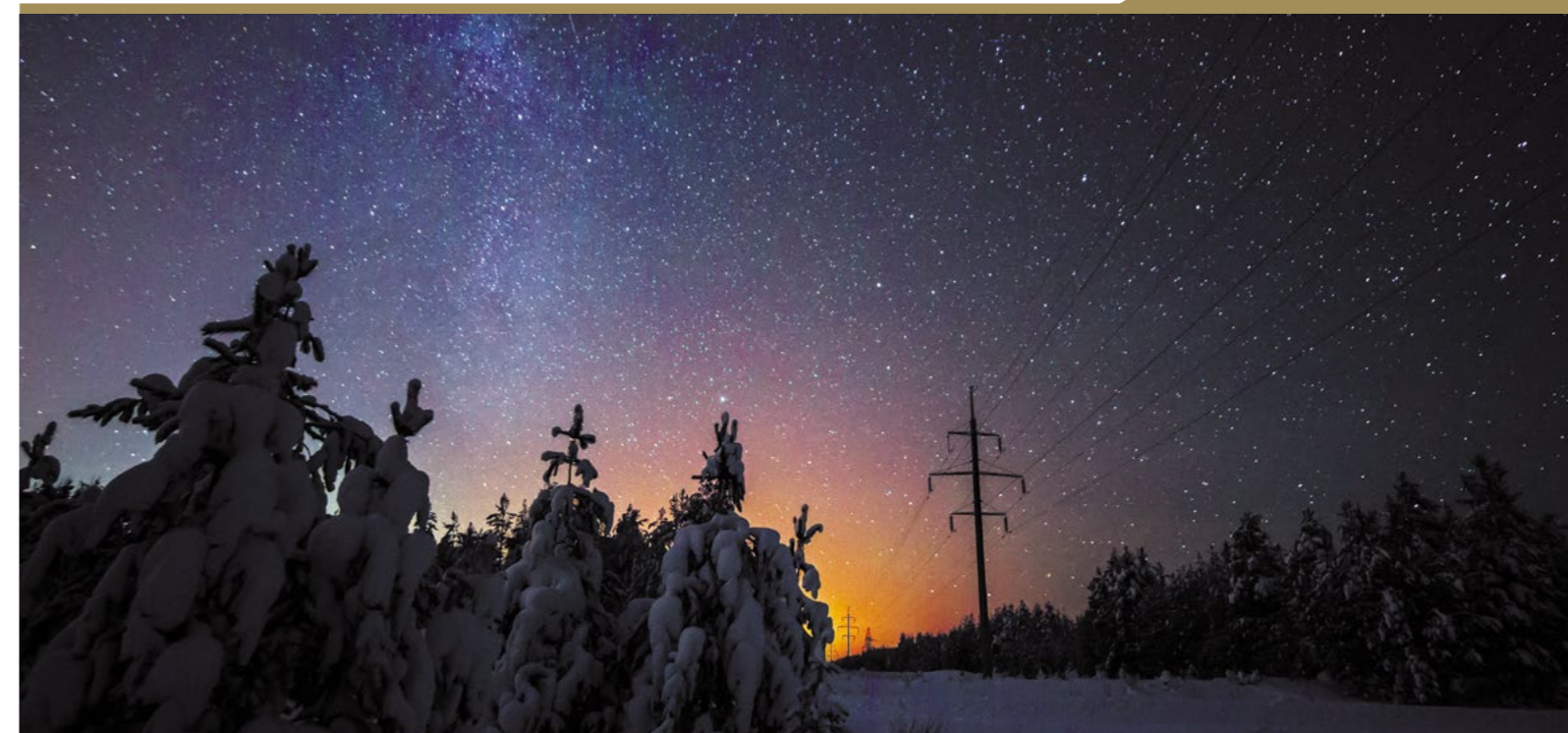
«Освещающая Млечный путь». Автор снимка Чаланов Иван Александрович, электромонтер по эксплуатации распределительных сетей 3 разряда филиала ПАО МРСК «Северо-Запада» «Комизнерго». На фотографии ВЛ-110 кВ от ПС «Усть-Кулом», с. Усть-Кулом, Республика Коми. 1 место в номинации «Природа» фотоконкурса «В гармонии с природой»
